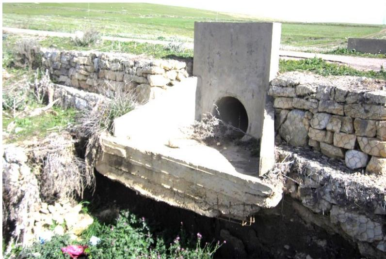
Figure II.13: Buse en bonne état avec affouillement en aval
