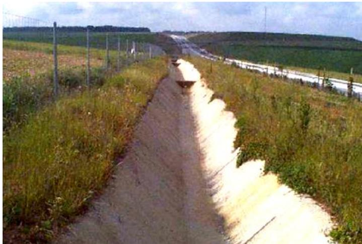
Figure III.10: Fossé trapézoïdal revêtu en béton muni de cloisons afin de limiter la vitesse des écoulements
