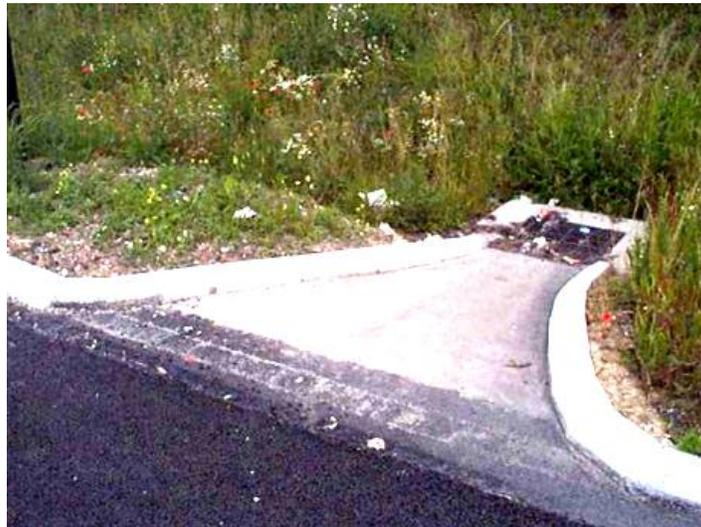
Figure III.18: Raccordement d'une bordure vers un regard à grille
