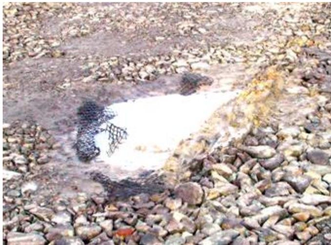
Figure II.9: Remontée des particules fines
