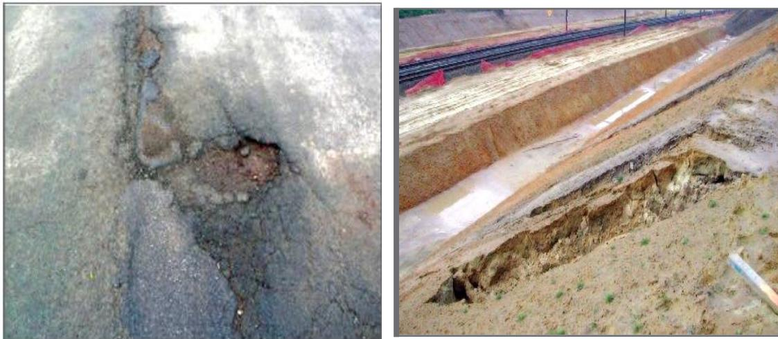
Figure II.10: Dégâts provoqués par l'eau et le gel
