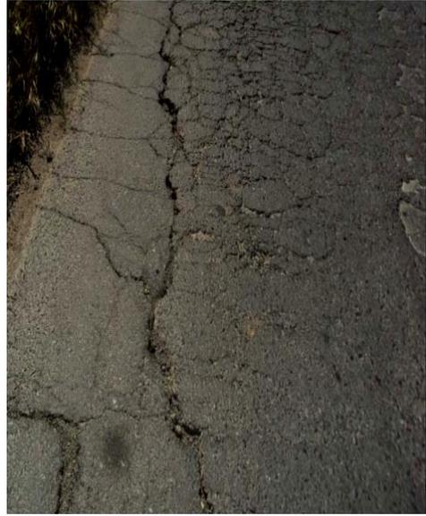
photographie de fissures longitudinales
