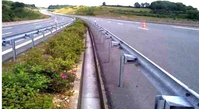
Figure III.17: Caniveau rectangulaire en béton à l'intérieur du TPC
