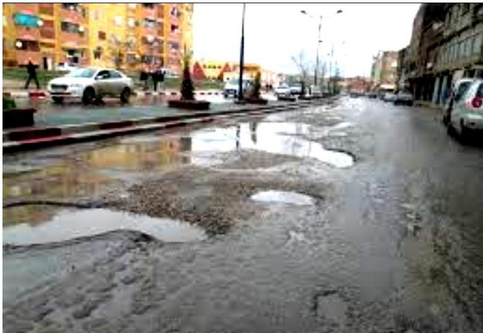
Figure IV.1. Chaussée dégradée (Tiaret)
