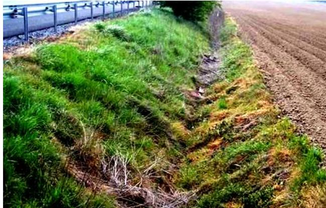
Figure III.15: Fossé trapézoïdal de pied de talus de remblais
