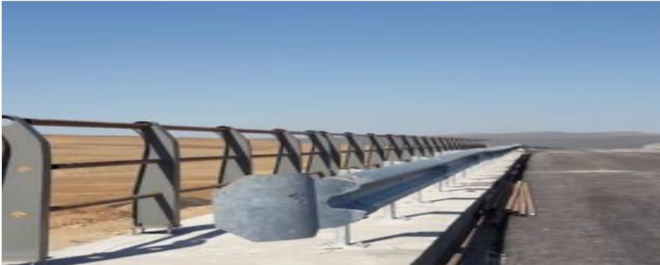
**Figure 13.3:** Les garde-corps en acier
