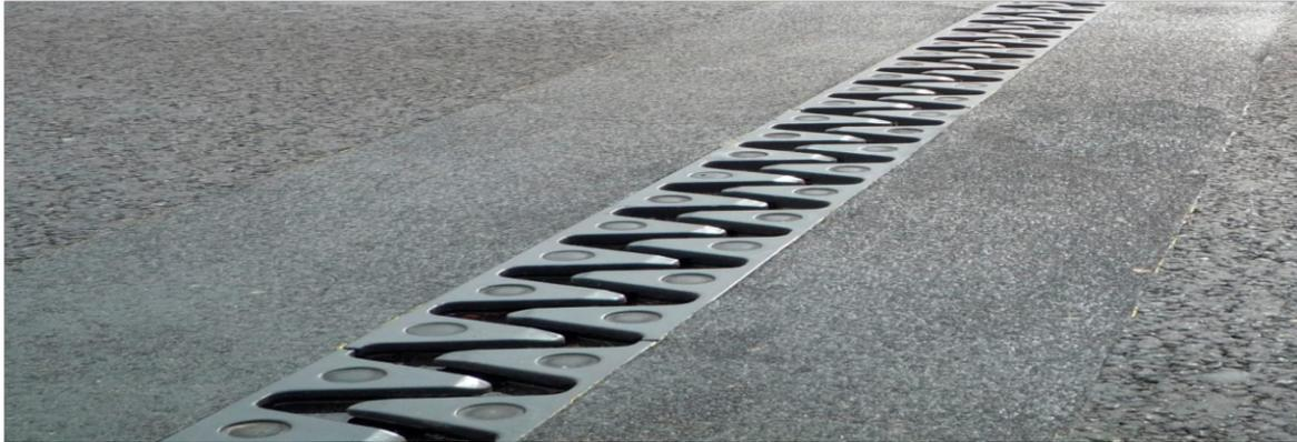
**Figure 13.2 : Joint de chaussée**
