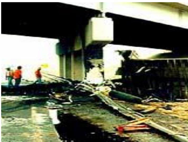
*Figure I.5 : Choc sur une pile de pont.*
