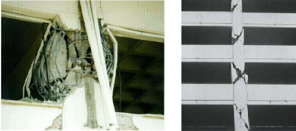
Figure III.6 : Fissures en croix d'effort tranchant (Northridge, Californie - USA, 1994)
