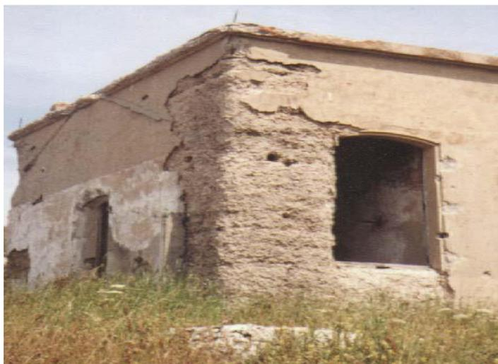
**Figure I.4 :** Dégradation d'un ouvrage soumis au gel dégel.
