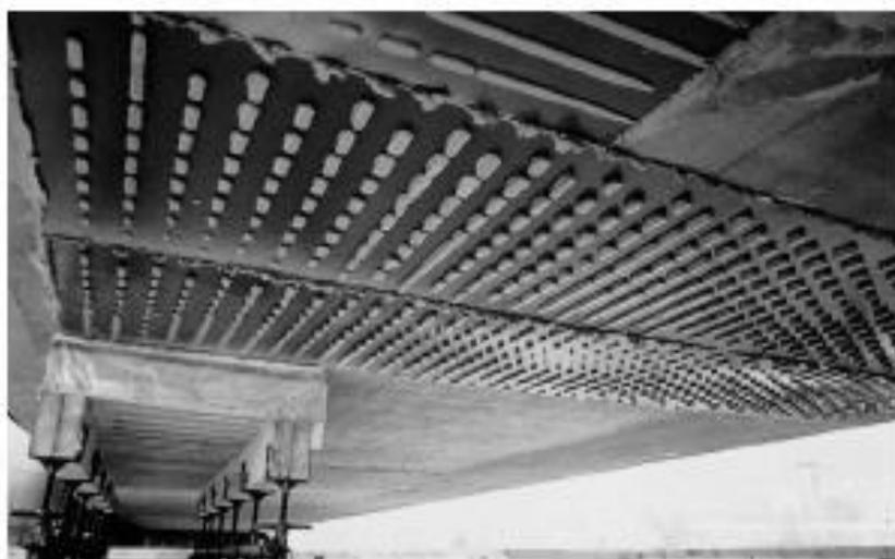
*Figure I.12 : Renforcement d'un viaduc par tôles collées.*
