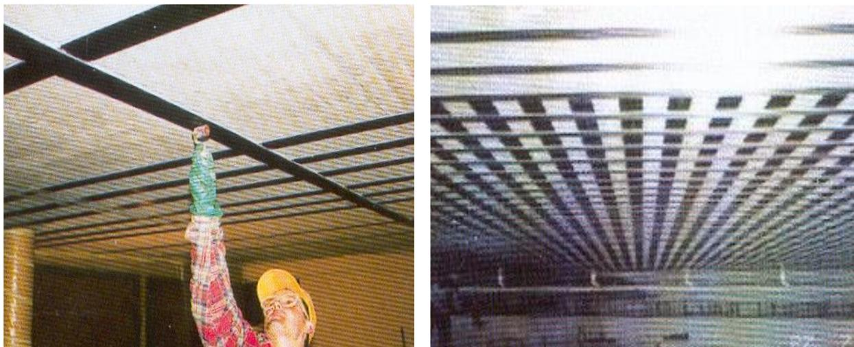
*Figure II.3 : dalles renforcées par matériaux composite*
