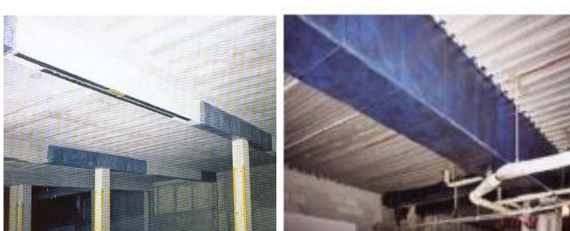
*Figure II.2 : renforcement des poutres a l'effort tranchant*
