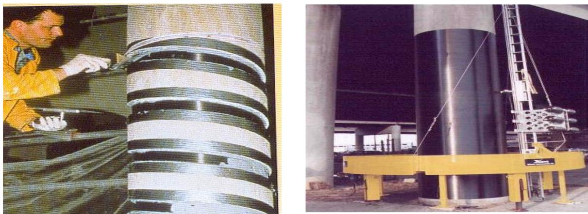
*Figure II.4 : colonnes renforcées par matériaux composites*
