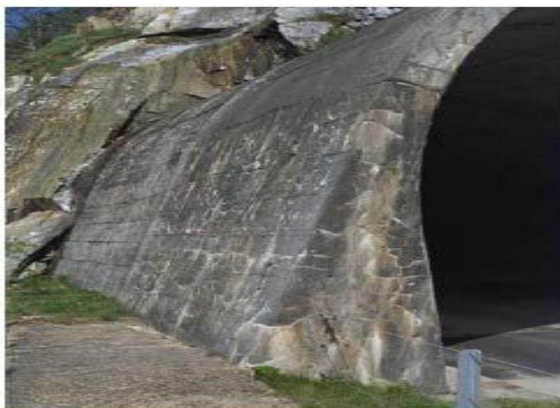
*Figure I.3 : Entrée d'un tunnel, Fissurations grossières dues à l'alcali-réaction.*
