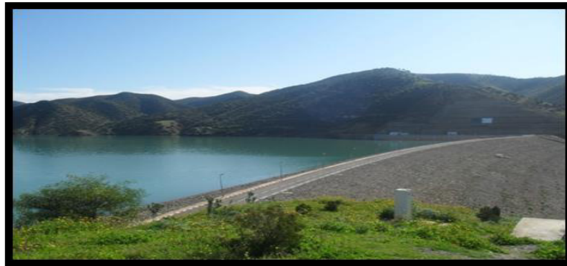
PHOTO N°01: Barrage de Gargar
