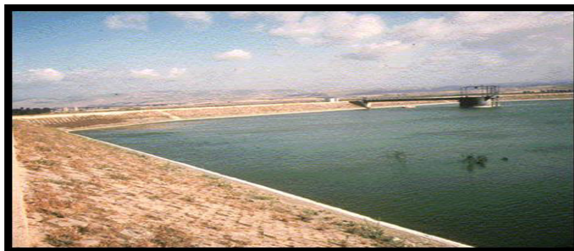
PHOTO N°02: Barrage de S.M.B.A
