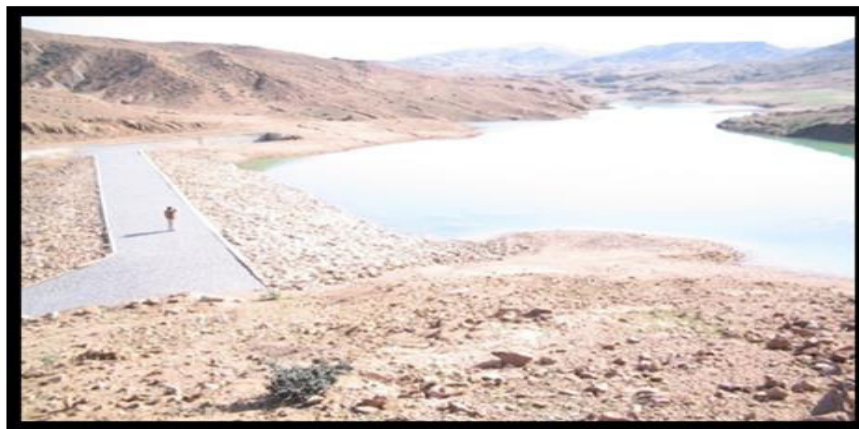
PHOTO N°05: Retenue Collinaire d'Oued Fardem.
