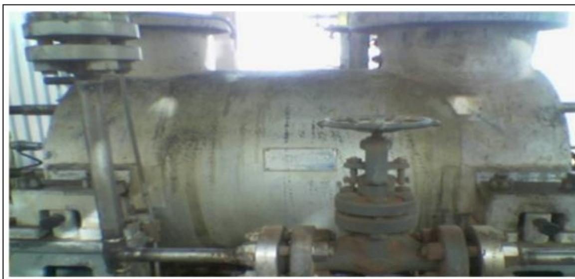
*FIG. III.4. Compresseur centrifuge BCL406 [15].*
