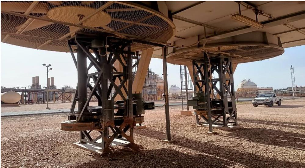
**Figure 3.3** : photo d'aéroréfrigérants
