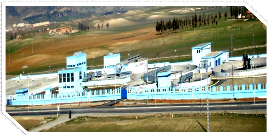
Figure n° 07: Vue générale de la station d'épuration de Tiaret (AZIBI, 2015).
