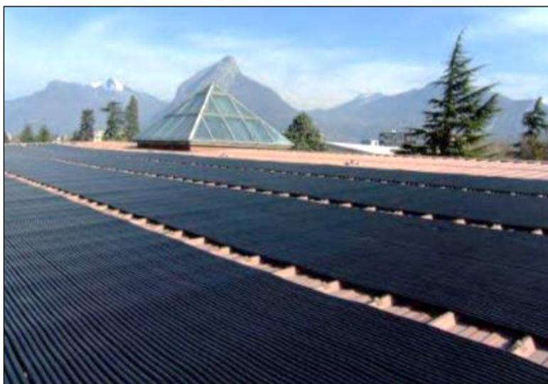
*Figure IV.4 : Capteurs non vitrés sur un toit de piscine*
