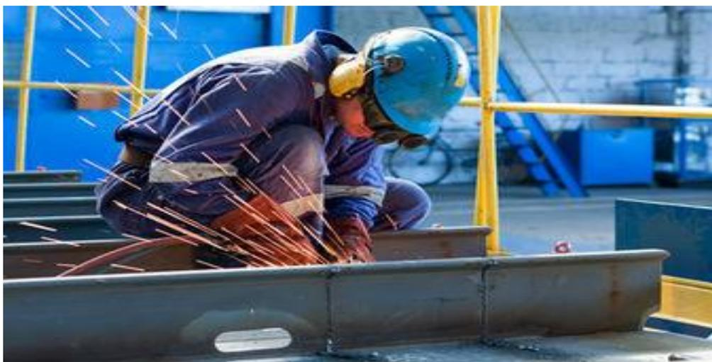
*Figure II.4 : Soudage à l'arc avec fil fourré [Fériel.Belcadhi, 2015].*
