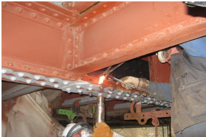
*Figure II.6 : Pose d'un rivet à tête ronde et gougeage de la tête de rivet. [BC METALNORD, 2009]*
