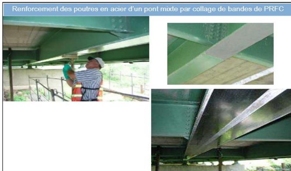
*Figure II.9: Différentes méthodes de renforcement par le collage de plaques en composites. [Perrier R. et al, 1996].*
