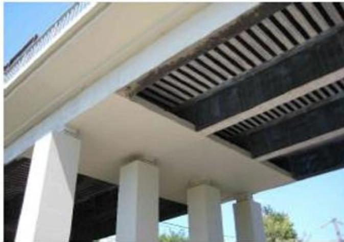
*Figure II. 12 : Tablier de pont renforcé par matériaux composites [BELBLIDIA Salima, 2018].*
