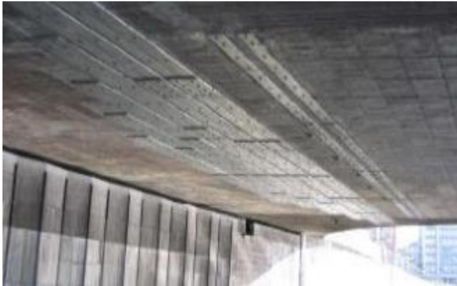
*Figure II.7 : Renforcement par plats métalliques [BELBLIDIA Salima, 2018].*
