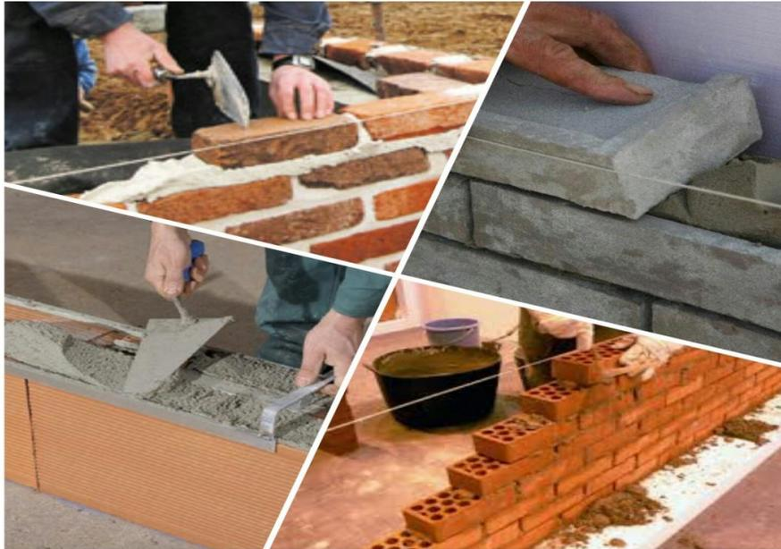
*Figure I.11. Les joints de maçonnerie*
