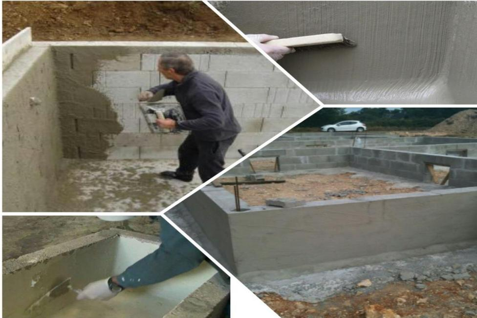
Figure I.7. Le mortier-hydrofuge
