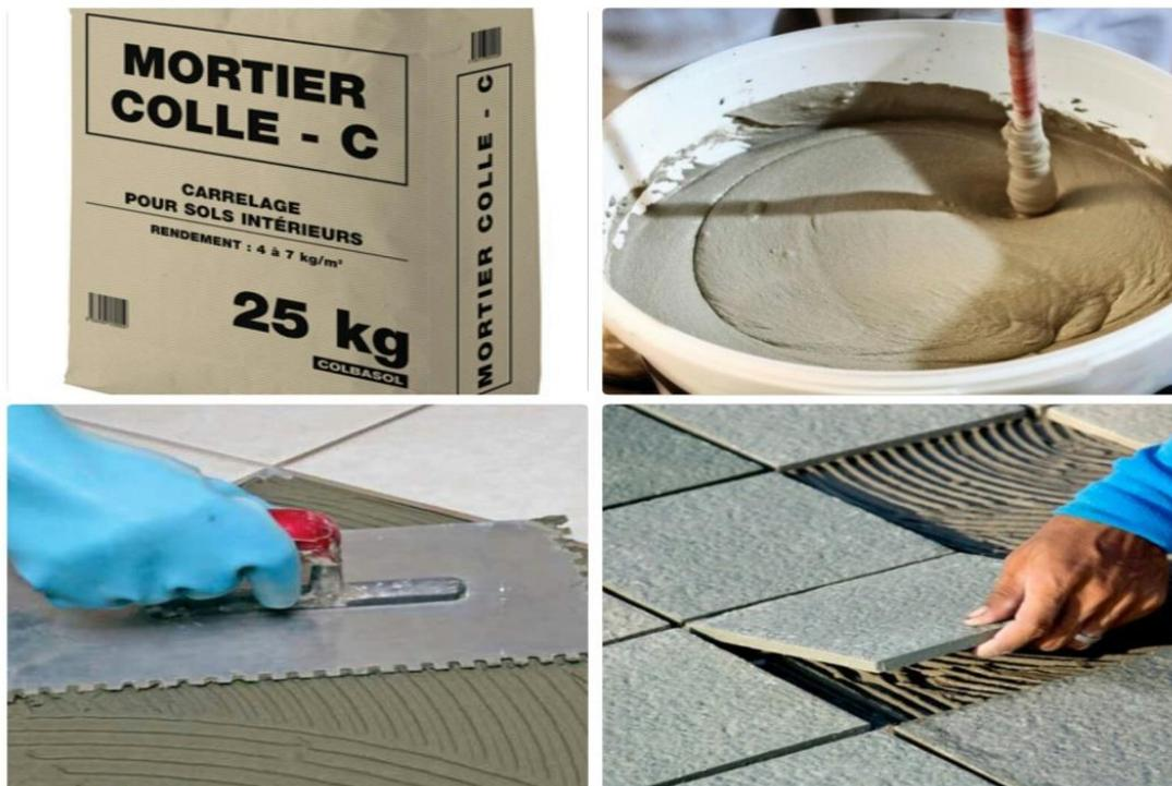
*Figure I.10. Le mortier-colle*
