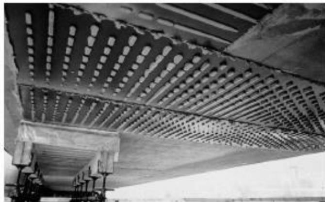
**Figure II.3.** Renforcement d'un viaduc par tôles collées (5)
