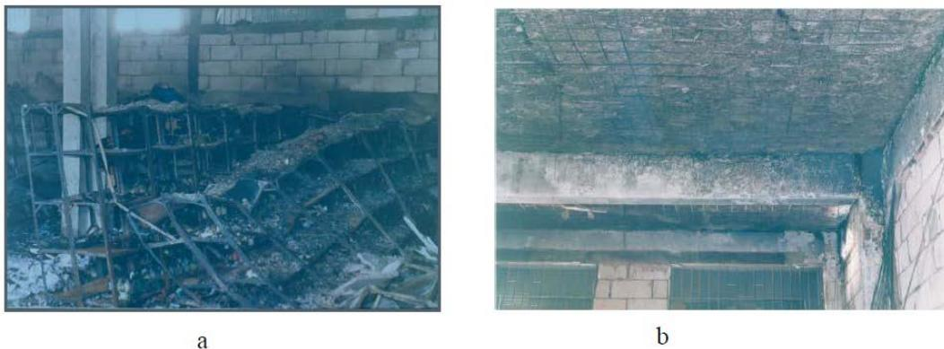
**Figure I.15:** Dégradation de la structure du supermarché de Annaba (8)
