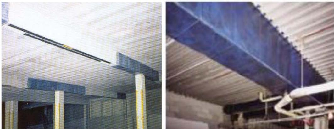
**Figure II.09.**renforcement des poutres a l'effort tranchant (12)
