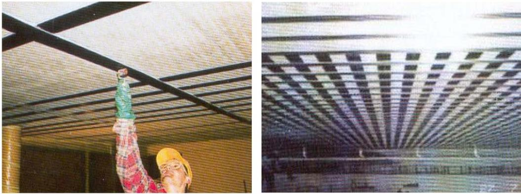
**Figure II.10.** dalles renforcées par matériaux composite (12)
