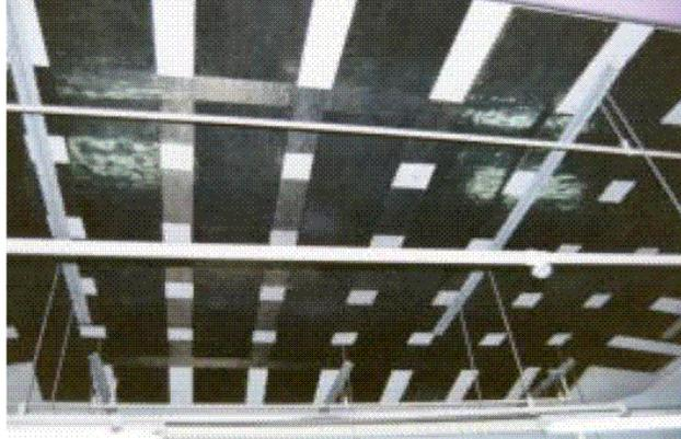
**Figure II.113.** Renforcement en flexion et de cisaillement d'une poutre en béton renforcée par des plaques en composite . (11)
