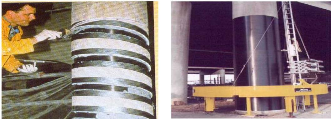
**Figure II.11.** colonnes renforcées par matériaux composites (12)
