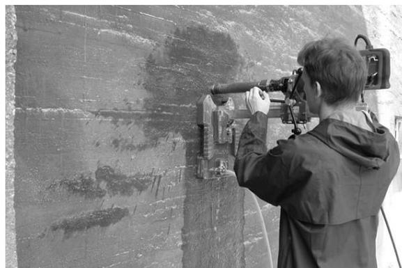
**Figure II.1.** Prélèvements par carottage (10)
