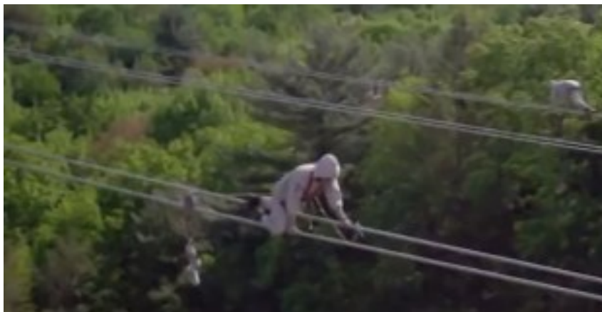
Figure III.55 image de nettoyage du les lignes de transmit
