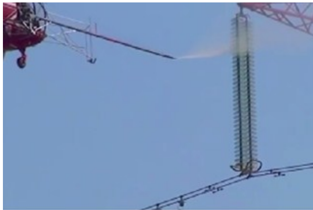
Figure III.52. Lavage des isolateurs
