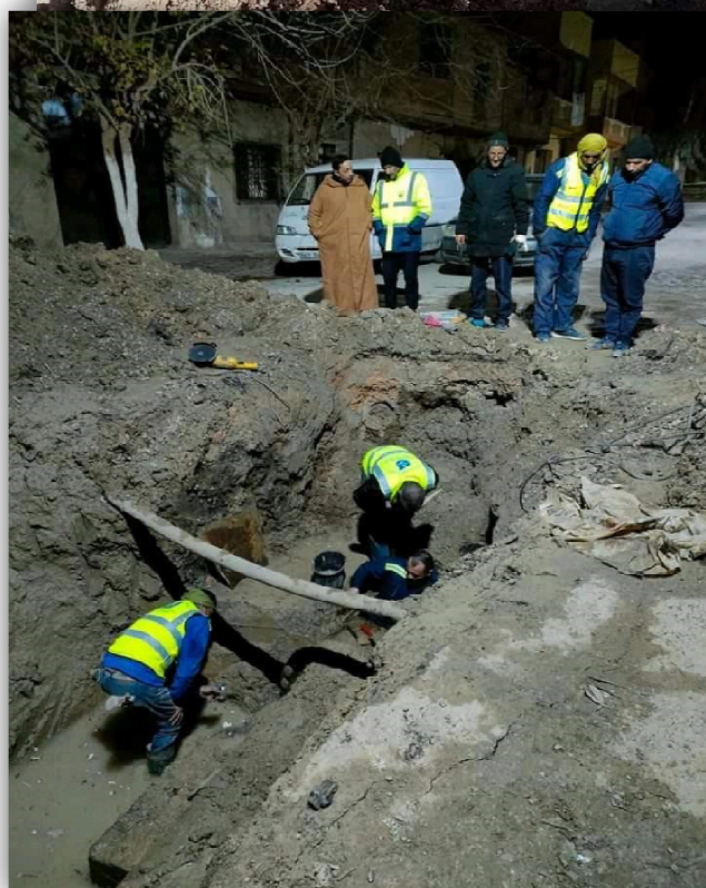
تدخلات الفرق التقنية التابعة لوحدة تيارت لإصلاح التسربات
