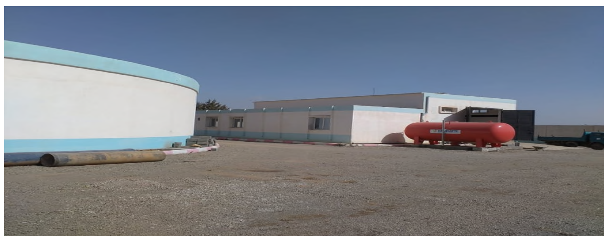
محطة الضخ «زعرورة» لتقوية تزويد شمال مدينة تيارت بالمياه الصالحة للشرب
