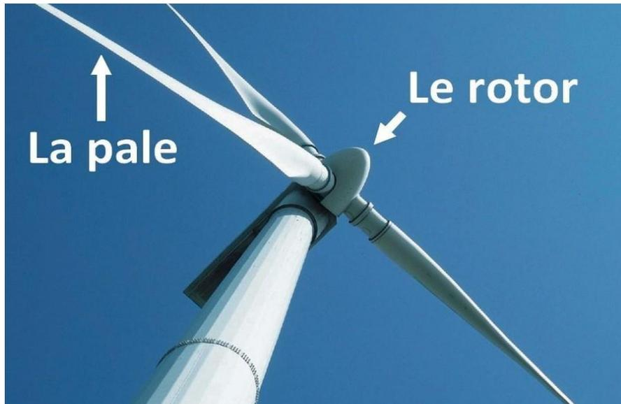
Figure II.6 : un rotor et les pales d'une éolienne à axe horizontal [39].
