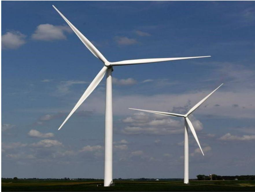
*Figure II.4 Turbine éolienne à axe horizontal (HAWT)*
