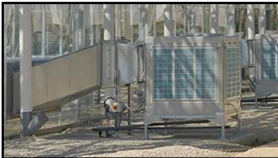
**Figure 1.9** *Les panneaux de refroidissement par évaporation*
