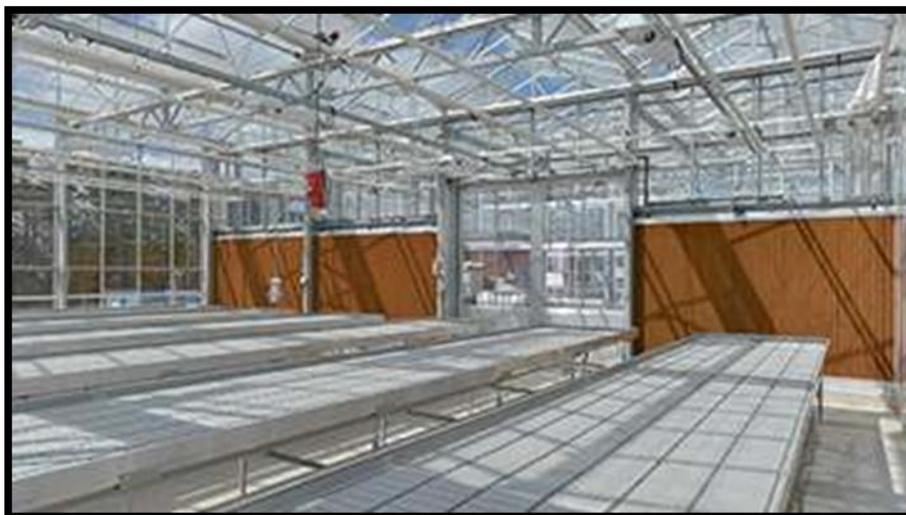
**Figure 1.8** *Les panneaux de refroidissement par évaporation [23]*
