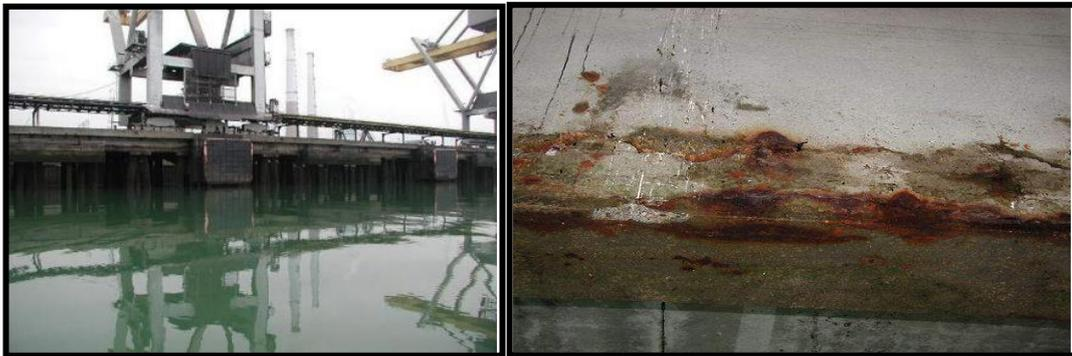
**Figure I.4:** Poutre située en bord de mer sous de l'agression des chlorures [8].
