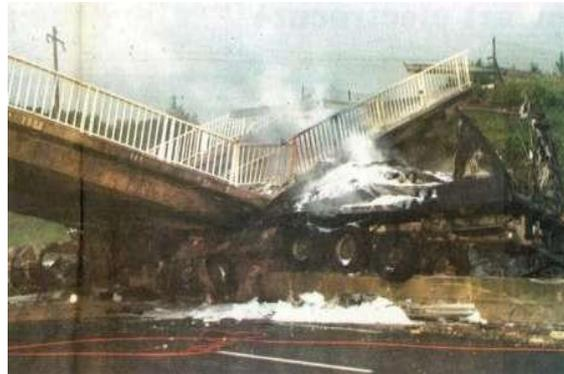
***Figure I.11: Effondrement d'un pont lors d'un violent choc de poids lourd[22]***
