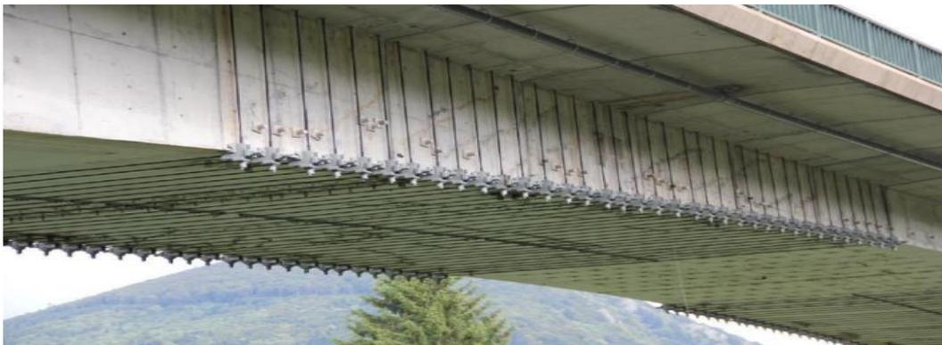
*Figure I.17: Application de la précontrainte additionnelle pour la réparation des ponts à poutres sous chaussée [30]*
