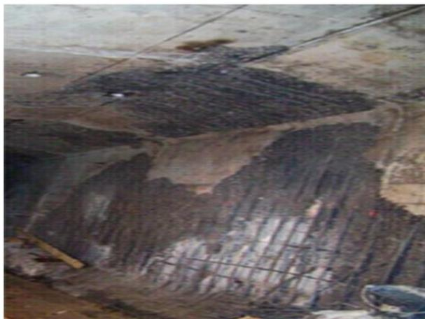
**Figure I.6:** structure en béton armé dégradée par le feu [13]
