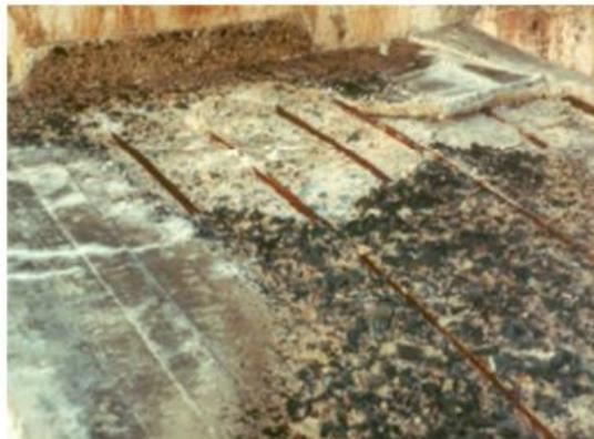
***Figure I.12: Délamination du béton [13]***
