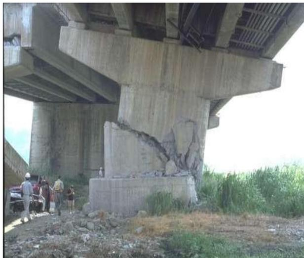
**Figure .I.10 :** Ruptures par cisaillement des piles (Taiwan, 1999) [22]
