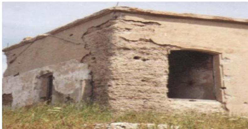
*Figure I.8 : Dégradation d'un ouvrage soumis au gel dégel [20]*
