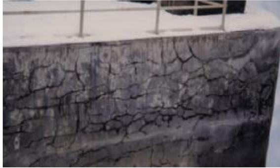
**Figure I.5:** Exemple de dégradations d'ouvrages dues à l'alcali-réaction [11]
