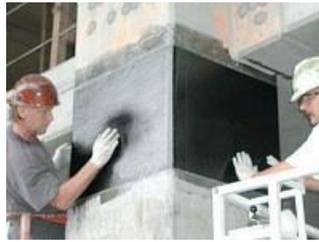
*Figure I.20: renforcement en fibres de carbone [36]*
