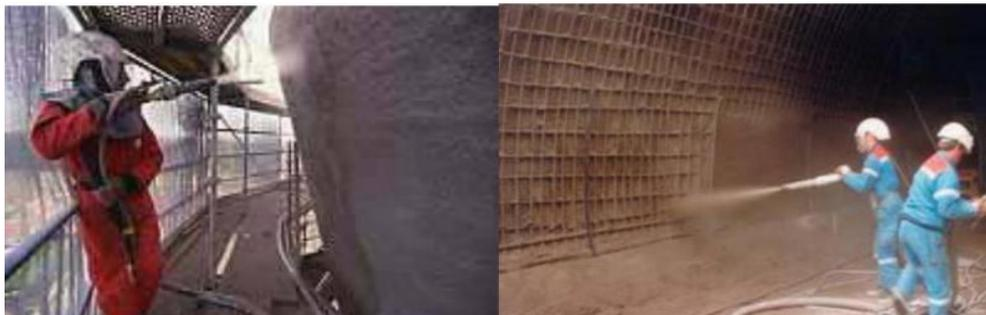
*Figure I.13: Renforcement au moyen de béton projeté[29].*
