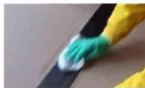
*Figure I.24: lissage de la surface de renforcement [36]*
