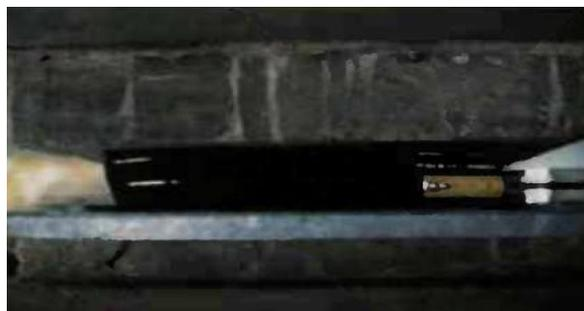
**Figure II.1** Ecrasement d'un appareil d'appui.
