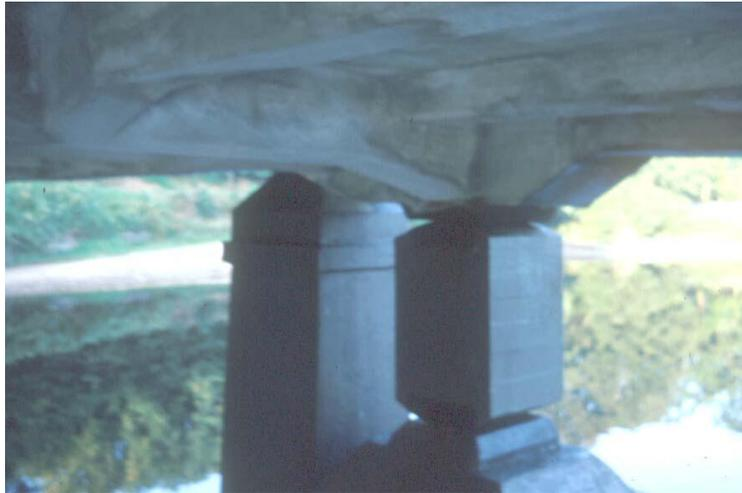
Figure I.7 Appareil d'appui en béton armé.
