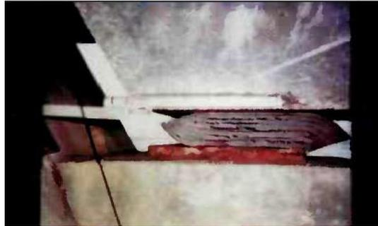
Figure II. 4 Déformation en S d'un appareil d'appui.
