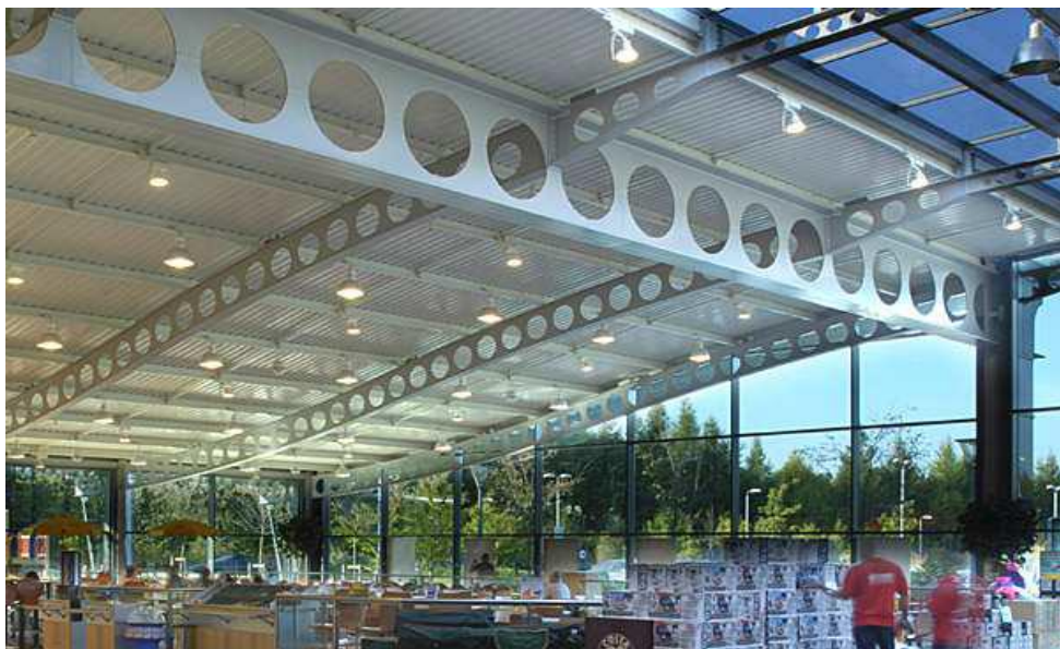
Figure 3 : Poutres cellulaires d'un toit courbé, Winchester
