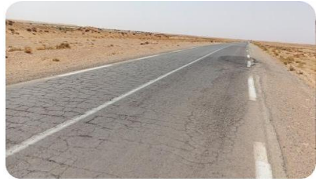
Affaissement de rive de Gravit  03
