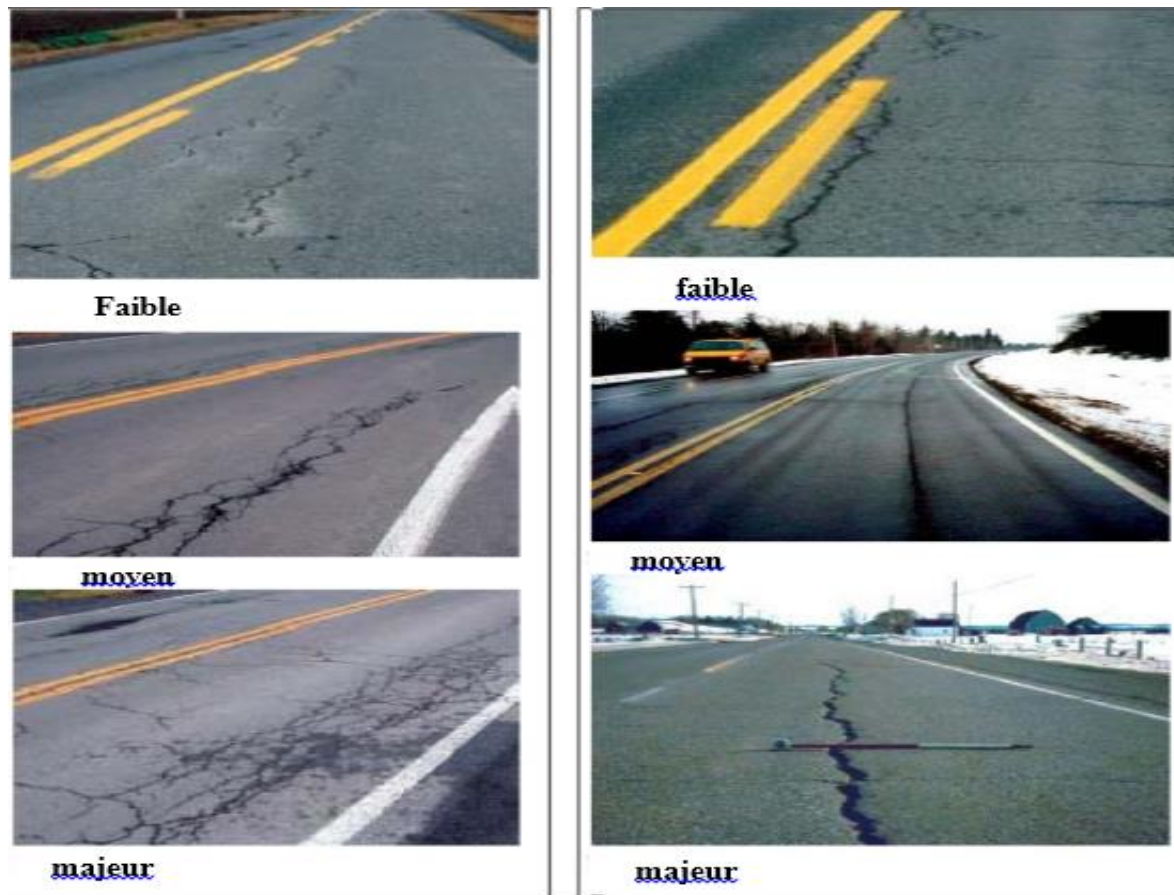
a. Fissures longitudinales en piste de roues) b.fissures longitudinales hors-piste de roues)
