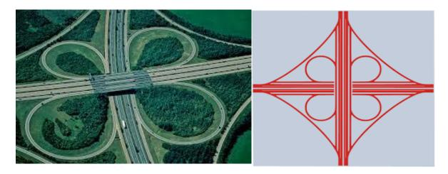
Figure II.2 : Echangeur autoroutier en trèfle complet.
