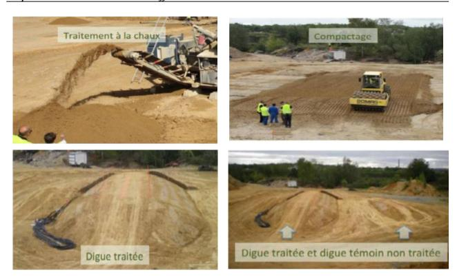
Figure 3.12: Traitement à la chaux (Projet Lhoist-Chan1er Pilote)
