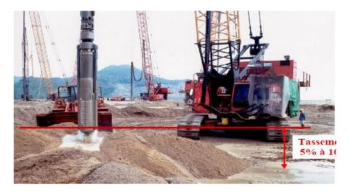
**Figure 3.3:** Vibrocompactage (Journée du 14 nombre 2012 : Procédés d'amélioration et de renforcement de sols sous actions sismiques)
