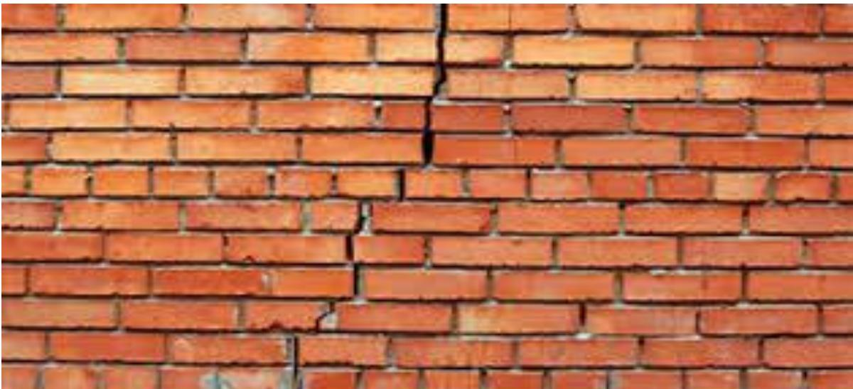
**Figure. I.17 :** fissuration au niveau des joints. [30]
