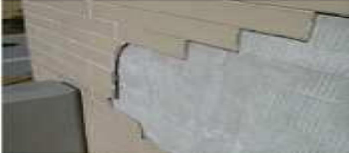
**Figure. I.16:** décollement de Figure carreaux. [30]
