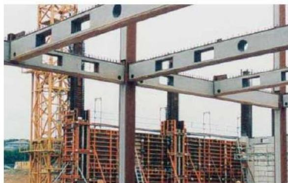
**Figure 1. 3.** Poutres reconstituées munies d'ouvertures isolées de la forme variées.
