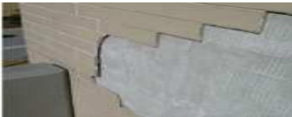
**Figure. I.18:** décollement de Figure carreaux.
