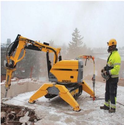
FIG I. 13 Robot de construction
