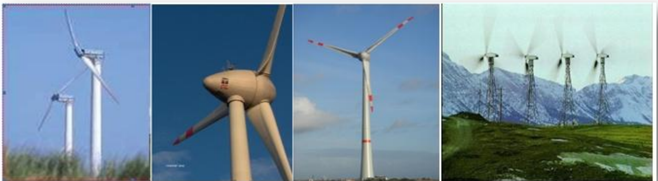
Fig.I.10 : Eoliennes à axe horizontal.
