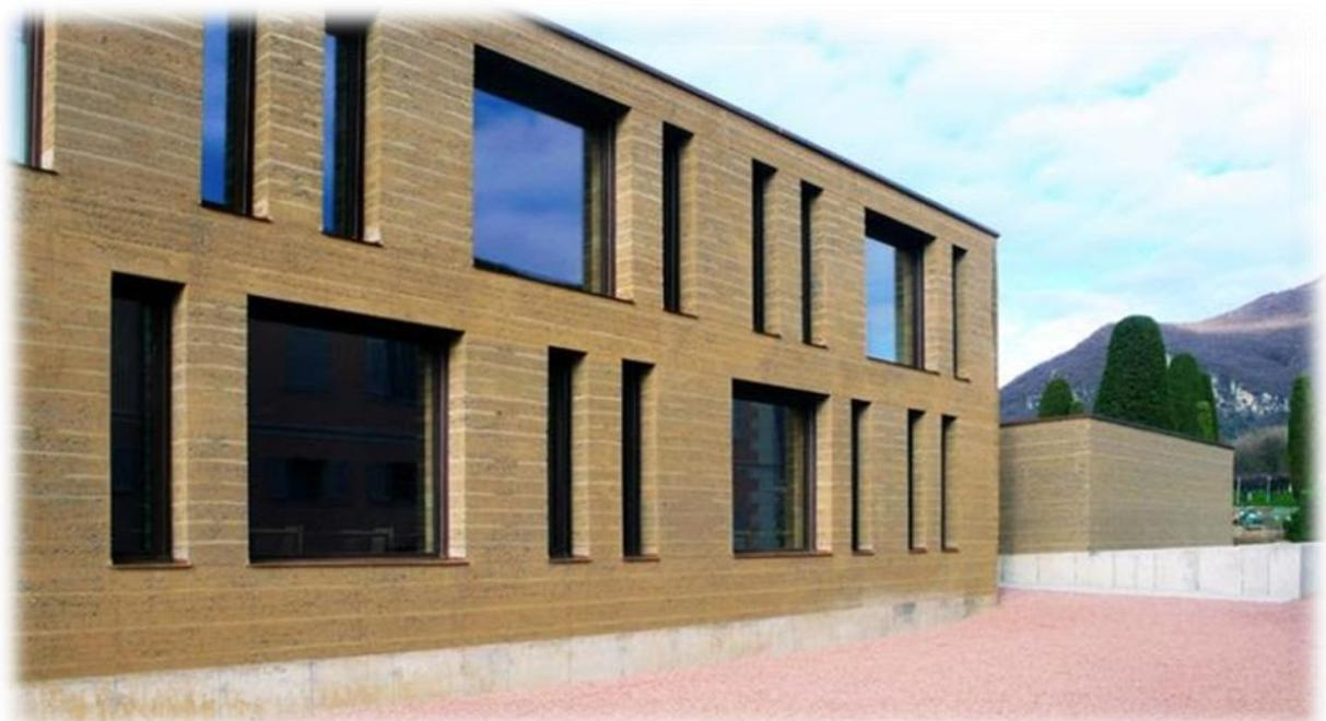
**Figure 12 :** construction moderne en murs de pisé. Autriche
