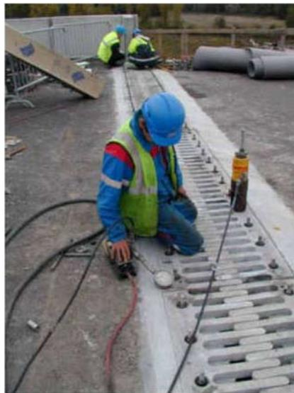
☞ *Figure IX.28.* Joint de chaussée
